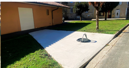
TRAVAUX RÉALISÉS PENDANT L'ÉTÉ
